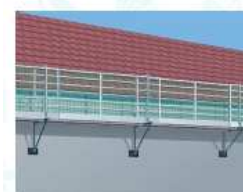
Console en périphérie de toiture
